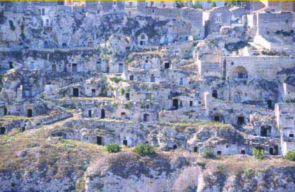
Foto 3. Los techos están tallados en la misma piedra y permiten que no se pierda ni una sola gota de agua. © Pietro Laureano
