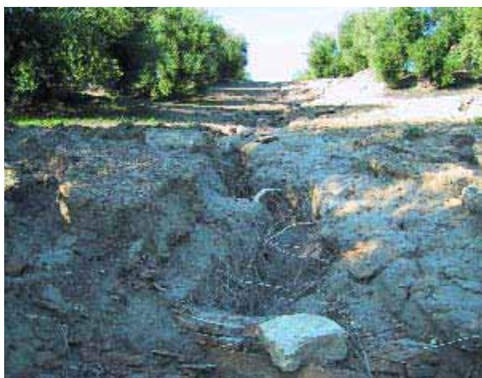
Foto 2. Terreno erosionado por el agua después de lluvias violentas.
