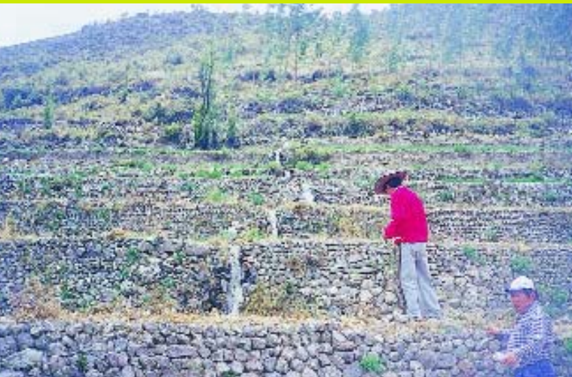
Photo 1. La réhabilitation des terrasses permet de cultiver les terres en pentes abruptes tout en évitant l'érosion. © PNUF
