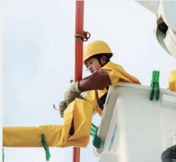
女工程师在高压电气系统上作业。 ©中国电气工程学会
