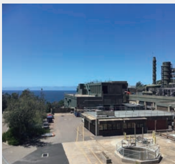
澳大利亚悉尼 North Head 废水处理厂处理过的污水产生的沼气用于发电。
