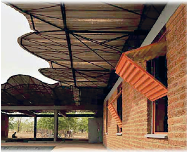
[사진 17] 자연 통풍을 통해 냉방이 가능한 학교 설계, 부르키나파소
